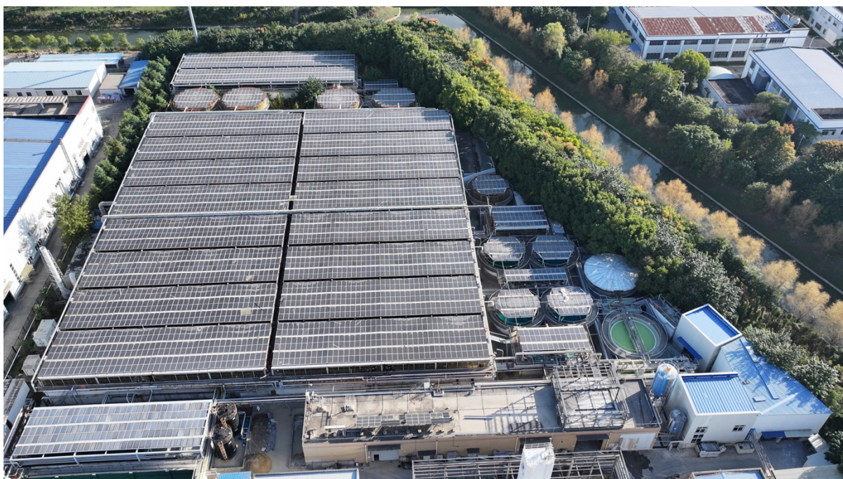
图 4-14 泰州隆基光伏科技有限公司屋顶光伏
