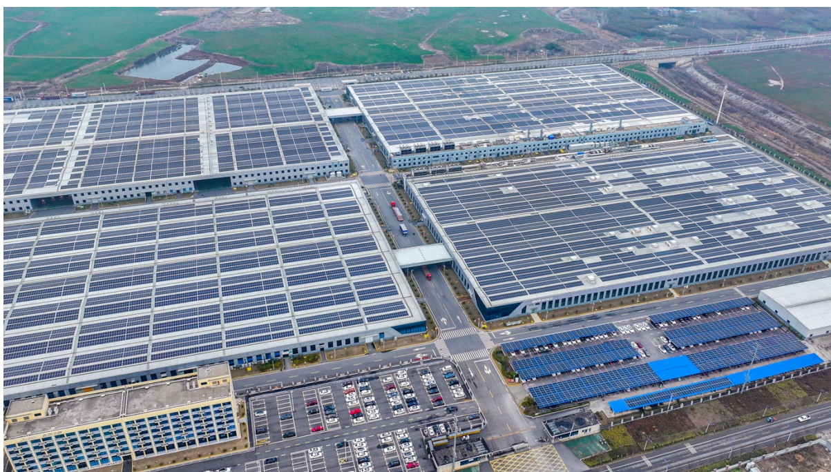
图 4-13 晶科能源（滁州）有限公司屋顶光伏
