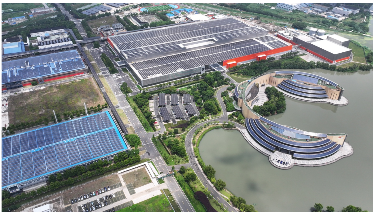
图 4-11 无锡中环应用材料有限公司屋顶光伏
