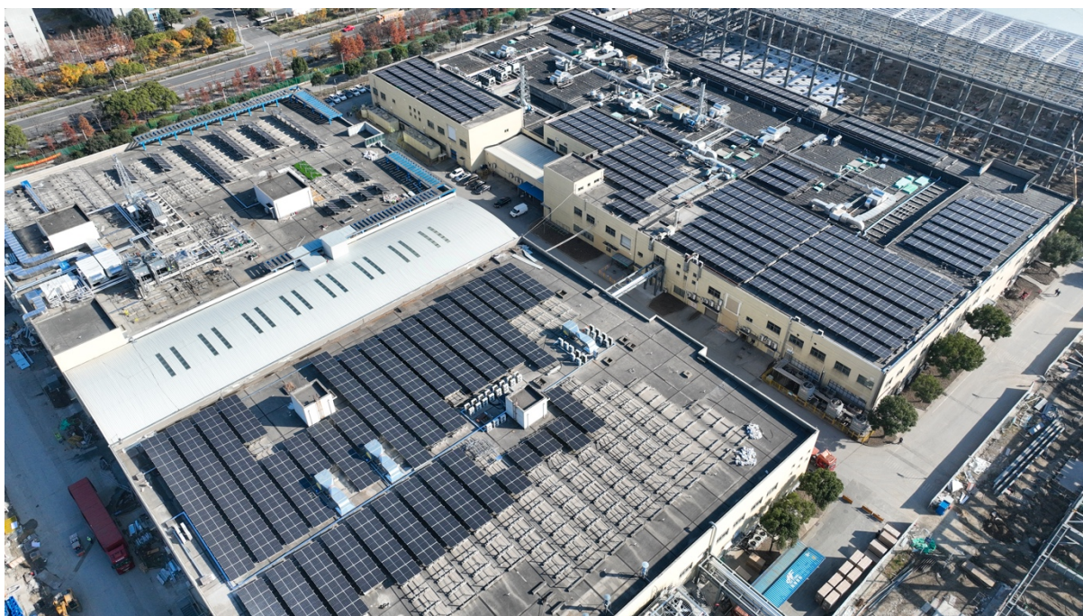
图 4-12 上海晶澳太阳能科技有限公司屋顶光伏
