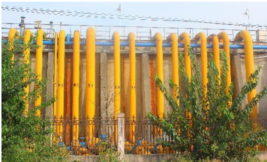
图 14 党湾污水处理厂各企业废水进水管道
