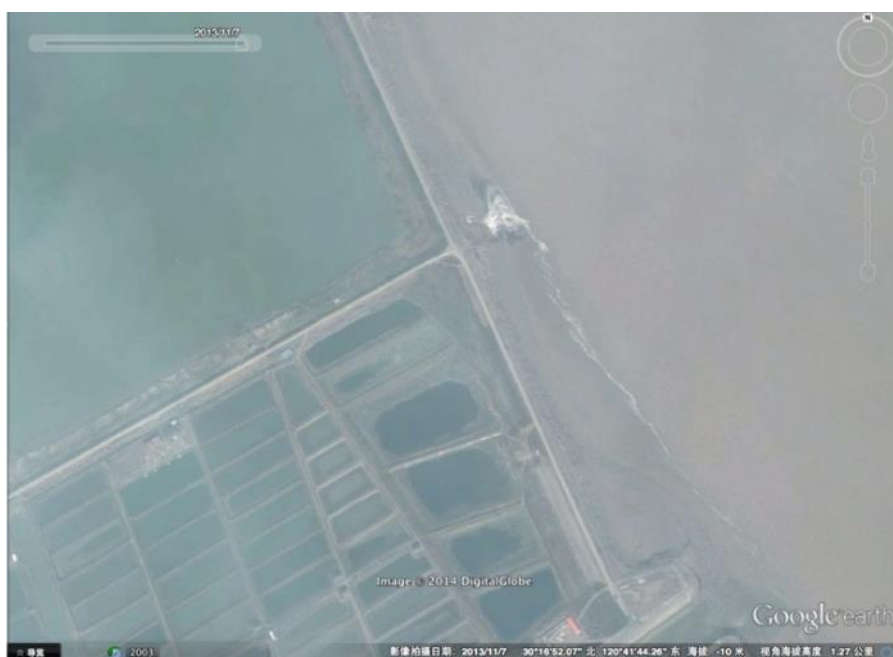
图 5 临江污水处理厂排口卫星图片（视角海拔高度 1.27 千米，2013. 11. 7. NASA 卫星拍摄）
