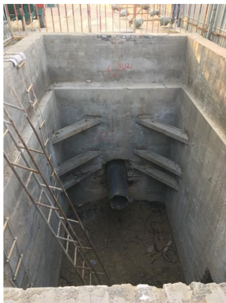
图 18 观音堂在建的地下污水管，IPE 沈苏南摄于 2017 年 11 月 4 日
