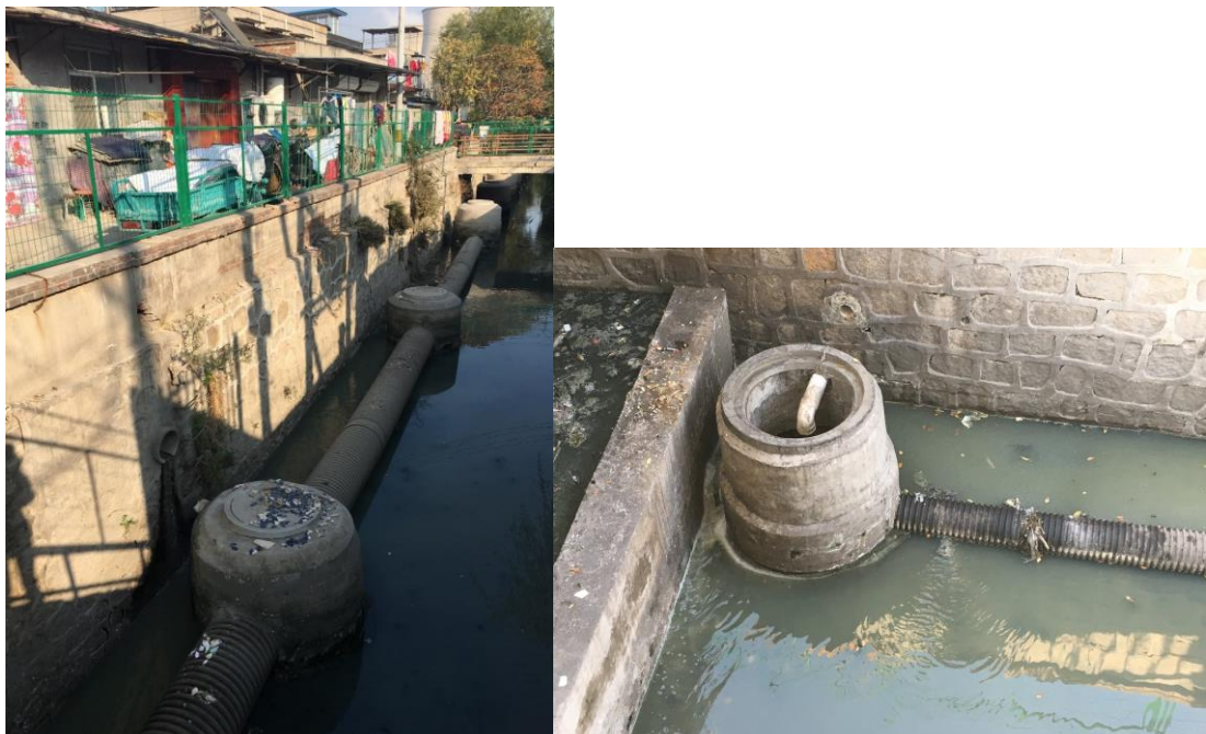
图 17 左、右：2017 年 11 月 4 日的观音堂沟，有臭味，沟里的污水管有多处破损，来自沟边居民区的部分生活污水直接排入沟中，IPE 沈苏宁摄
