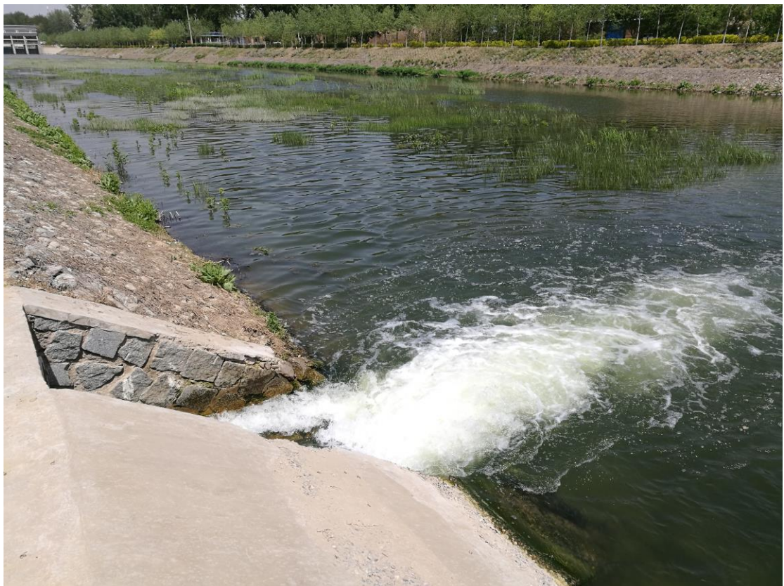
图 14 垡头污水处理厂排水口，该污水厂收集处理萧太后河的污水，再补充到通惠河灌渠。IPE
