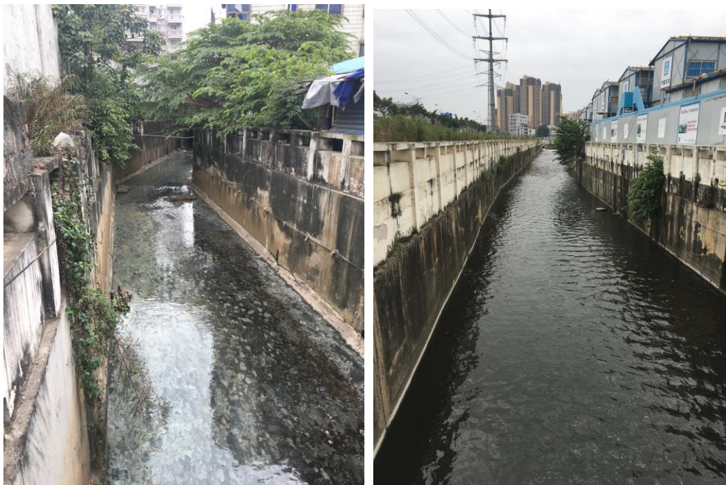
图 39 左图：道客沟下段（道客路-道客新村一横街），右图：道客沟上段（烟草公司宿舍-道客路），IPE 沈苏南摄于 2018 年 2 月 8 日
