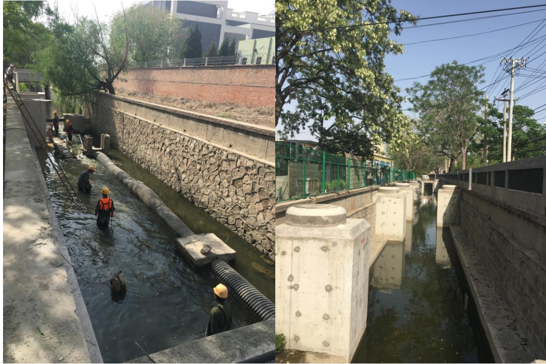
图 20 左图：工人正在从沟底搬出施工时的沙袋。右图：起始段。IPE 沈苏宁摄于 2018 年 4 月 27 日
